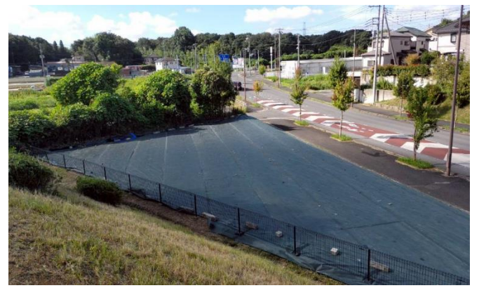
◆夏の暑い時期、早朝 2 時間限定で作業を実施 ◆防草シート施工が完了（2024 年 9 月）
