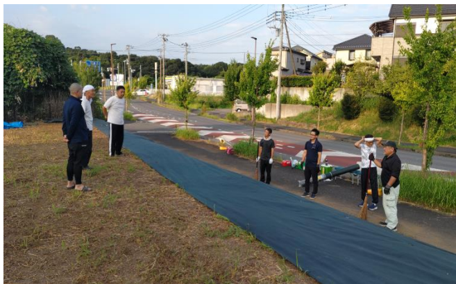
◆夏の暑い時期、早朝 2 時間限定で作業を実施 ◆防草シート施工が完了（2024 年 9 月）
