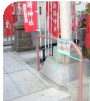
手すりを取り付けました
