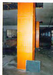
(鋼板巻き立て後)
