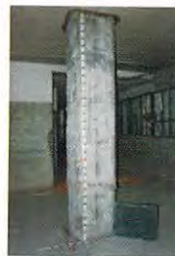
(仕上げ材の撤去後)
