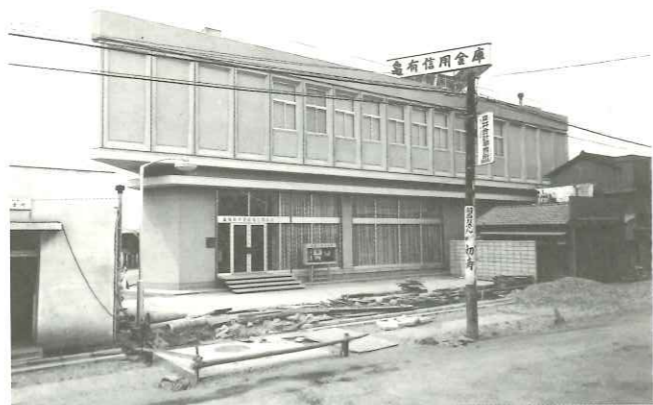
亀有信用金庫前で暗渠の工事中
