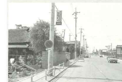
暗渠工事終了
