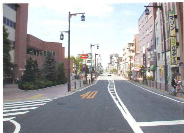
駅周辺の道路は電柱が地中化されている
