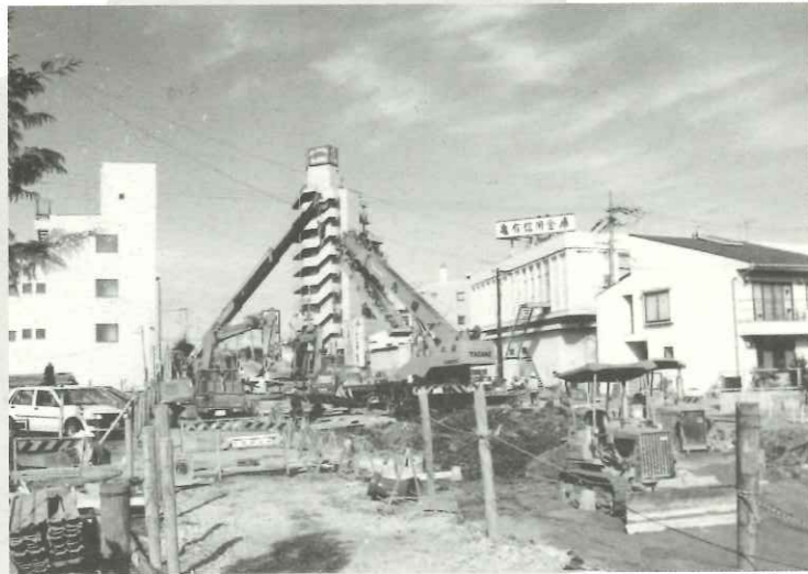
大規模な100号線工事
